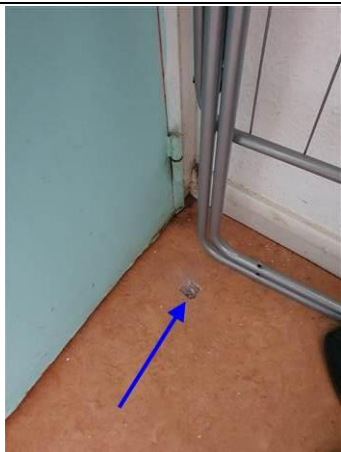
Photo n° PhA093 Localisation : 4ème étage - N4-29 Chambre 420 Ouvrage : 5 - Planchers et planchers techniques - Revêtements de sols Partie d'ouvrage : Sol Description : Matériau de type colle (jaune) en traces ; matériau semi-dur de type ragréage (rose)
