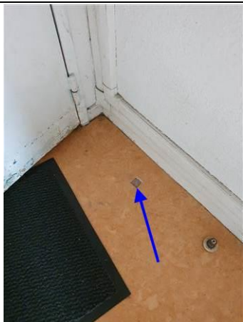
Photo n° PhA177 Localisation : 8ème étage - N8-37 Chambre 822 Ouvrage : 5 - Planchers et planchers techniques - Revêtements de sols Partie d'ouvrage : Sol Description : Lino + colle + ragréage
