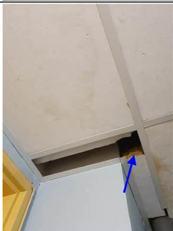
Photo n° PhA239 Localisation : Rez de chaussée - N0-29 WC Ouvrage : 4 - Plafonds et faux plafonds - Faux plafonds Partie d'ouvrage : Plafond Description : Matériau de type peinture (blanc) ; matériau de type colle (jaune) en traces ; matériau fibreux de type isolant (jaune) en traces
