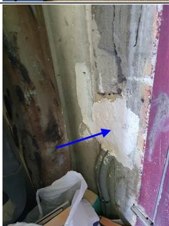
Photo n° PhA186 Localisation : 10ème étage - N10-39 Circulation Ouvrage : 3 - Parois verticales intérieures - Murs et cloisons maçonnés Partie d'ouvrage : Mur Description : Scellement plâtre
