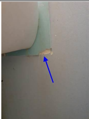
Photo n° PhA238 Localisation : Rez de chaussée - N0-29 WC Ouvrage : 3 - Parois verticales intérieures - Murs et cloisons maçonnés Partie d'ouvrage : Mur Description : Faïence + colle
