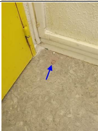
Photo n° PhA036 Localisation : 2ème étage - N2-46 Chambre 203 Ouvrage : 5 - Planchers et planchers techniques - Revêtements de sols Partie d'ouvrage : Sol Description : Ragréage + colle noire
