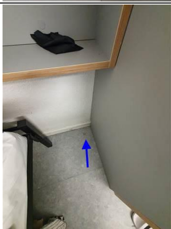
Photo n° PhA123 Localisation : 6ème étage - N6-17 Chambre 609 Ouvrage : 5 - Planchers et planchers techniques - Revêtements de sols Partie d'ouvrage : Sol Description : Matériau souple de type revêtement de sol (bleu) (tacheté)
