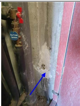
Photo n° PhA141 Localisation : 6ème étage - N6-41 Circulation Ouvrage : 3 - Parois verticales intérieures - Murs et cloisons maçonnés Partie d'ouvrage : Mur Description : Scellement plâtre
