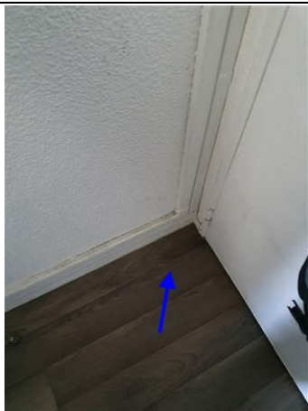
Photo n° PhA188 Localisation : 9ème étage - N9-48 Chambre 902 Ouvrage : 5 - Planchers et planchers techniques - Revêtements de sols Partie d'ouvrage : Sol Description : Lino + colle + ragréage
