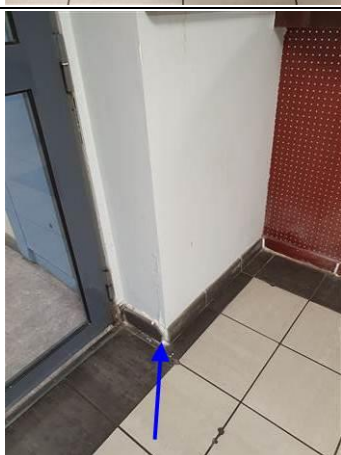
Photo n° PhA255 Localisation : Rez de chaussée - N0-32 Entrée Ouvrage : 3 - Parois verticales intérieures - Murs et cloisons maçonnés Partie d'ouvrage : Plinthe Description : Matériau dur de type carrelage, faïence (noir) ; matériau dur de type ciment-colle (gris)
