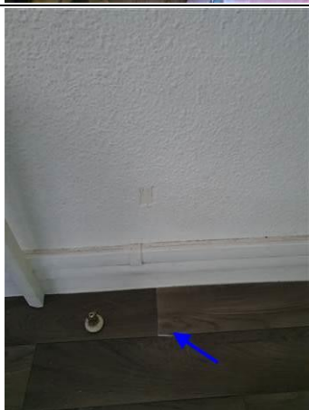
Photo n° PhA142 Localisation : 7ème étage - N7-39 Chambre 704 Ouvrage : 5 - Planchers et planchers techniques - Revêtements de sols Partie d'ouvrage : Sol Description : Lino + colle + ragréage
